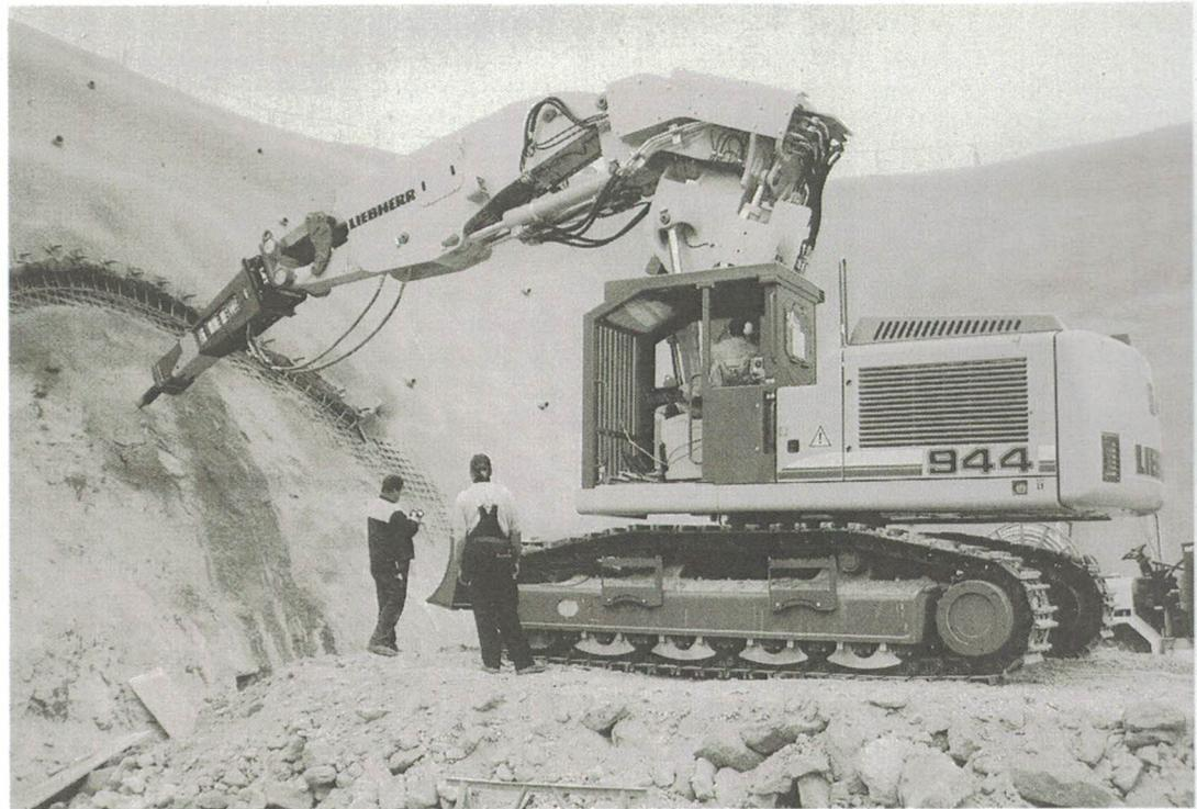
Tunnelanschlag: Pionier beim Weg-frei-machen durch den Tunnel war der XB 2300 iS Hydraulikhämmer der LST. Mit fast 3 t Eigengewicht arbeitete er an einem Liebherr-Raupenhydraulikbagger R944C. Foto: LST
