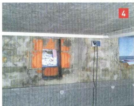
Kellerraum vor der Sanierung: Der Raum wurde mit „Sikusan-Gewebe“ präpariert, der Mauerwerksdurchbruch für das „freeAir 100“ vorbereitet.
