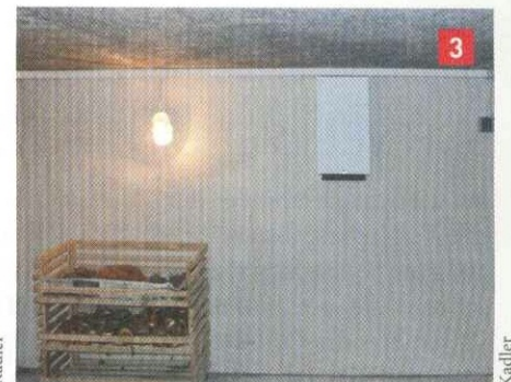
Kellerraum nach der Sanierung: Mit dem „Sikusan-Klimaputz“ und dem „freeAir 100“-Lüftungssystem wird ein frisches Kellerklima geschaffen.
