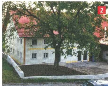
Altes Haus mit neuem Gesicht: Passende Sanierungsmaßnahmen erhalten ein harmonisches Gesamtbild des denkmalgeschützten Gebäudes.
